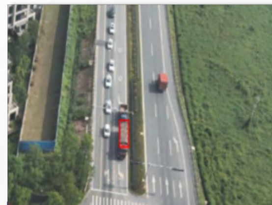
渣土车未覆盖
